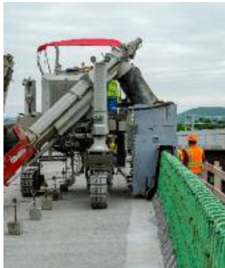
Pouring barrier over rebar cage.
